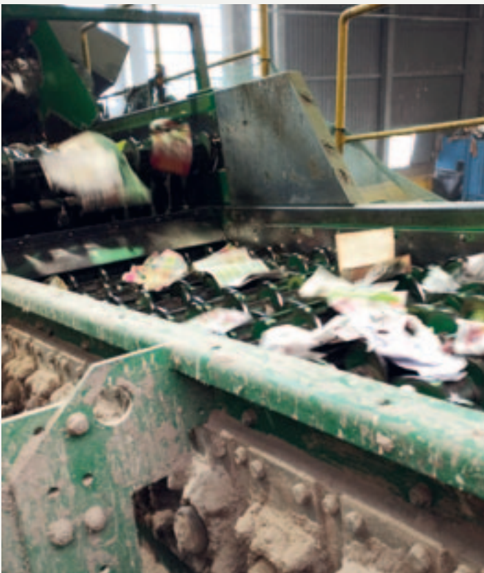
Wellenförderband, um Kleinmaterial auszusortieren.
