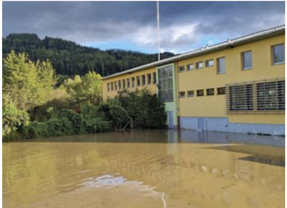
Bild: E-Werk Kindberg; Betriebsgebäude E-Werk Kindberg!
